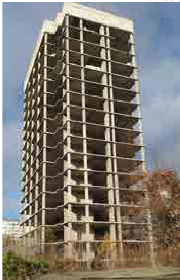
Рис. 1. Каркас здания на основе КУБ-2,5
