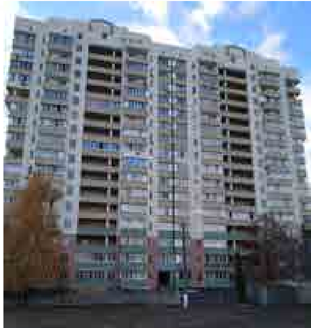
Рис. 2. Жилое здание, возведенное по системе СМКУБ
